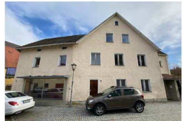
Ansicht von Westen (Hammerstraße)
