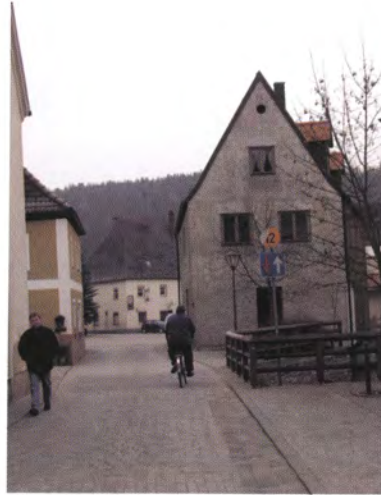
"Doppelbrücke" am östlichen Ortseingang
