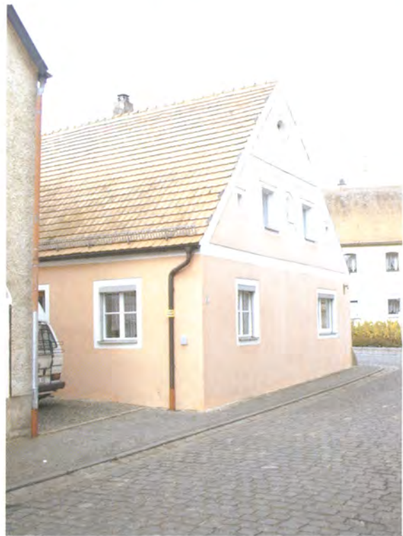
←↑ Typische Beispiele für Trauf- und Ortganganschlüsse aus Schmidmühlen
