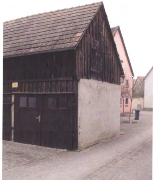
Dieser Stadel markiert den Zugang zum äußeren Hammerviertel von Norden her.
