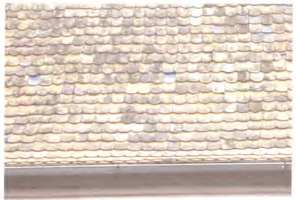
Biberschwanz-Einfachdeckung auf Haupt- und Nebengebäuden im Ökonomenhof des Hammerschlusses.
