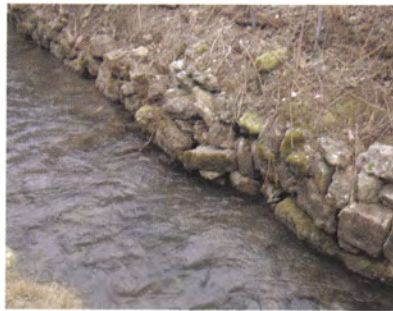
Uferbefestigung mit Natursteinmauern
