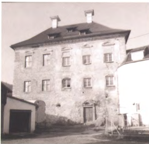
Hammerschloß vor der Sanierung
