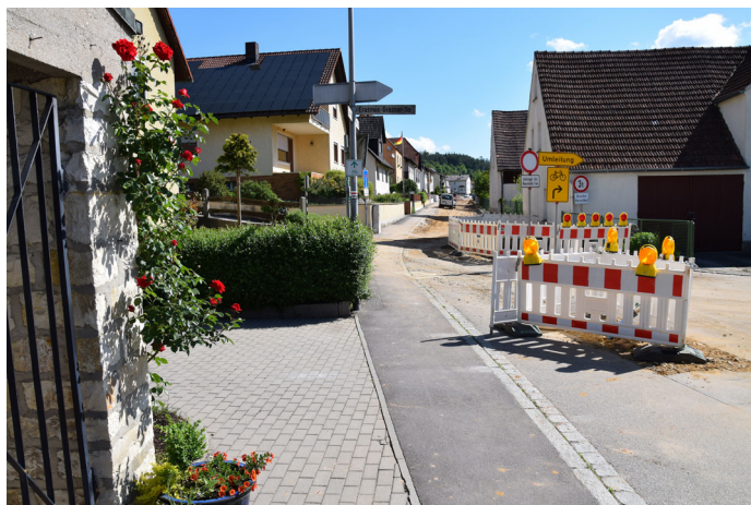
Auf der Baustelle läuft's gut. Da danke ich den Anliegern in der Harschhofer Strasse, dass sie den Komplettausbau so aufgeschlossen gegenüberstehen“, meinte Bürgermeister Peter Braun. Fotos © Paul Böhm
