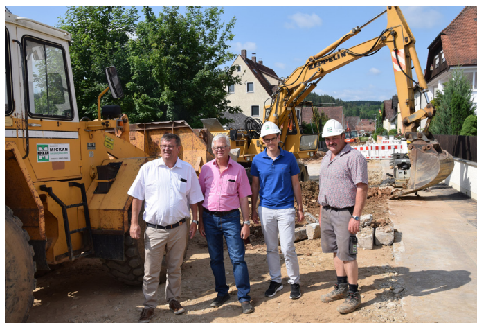
Jour Fixe mitten in der Baustelle in der Harschhofer Straße. Der erste Bauabschnitt ist gut angelaufen. Derzeit ist man dabei die Versorgungsleitungen zu sichern. Von links Bürgermeister Peter Braun, Karl Heinz Schmidt von den UTA Ingenieuren aus Amberg, Bauingenieur Tobias Weininger von der Baufirma Mickan und Albert Hausmann, Polier und Ansprechpartner vor Ort im Bereich der Baustelle.
