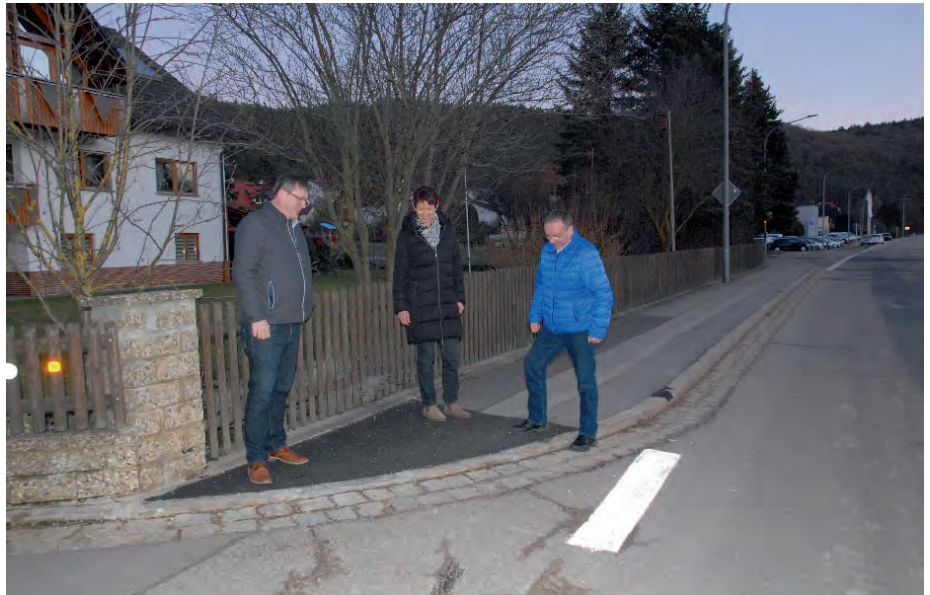
Gehwegabsenkungen wurden bereits realisiert.
